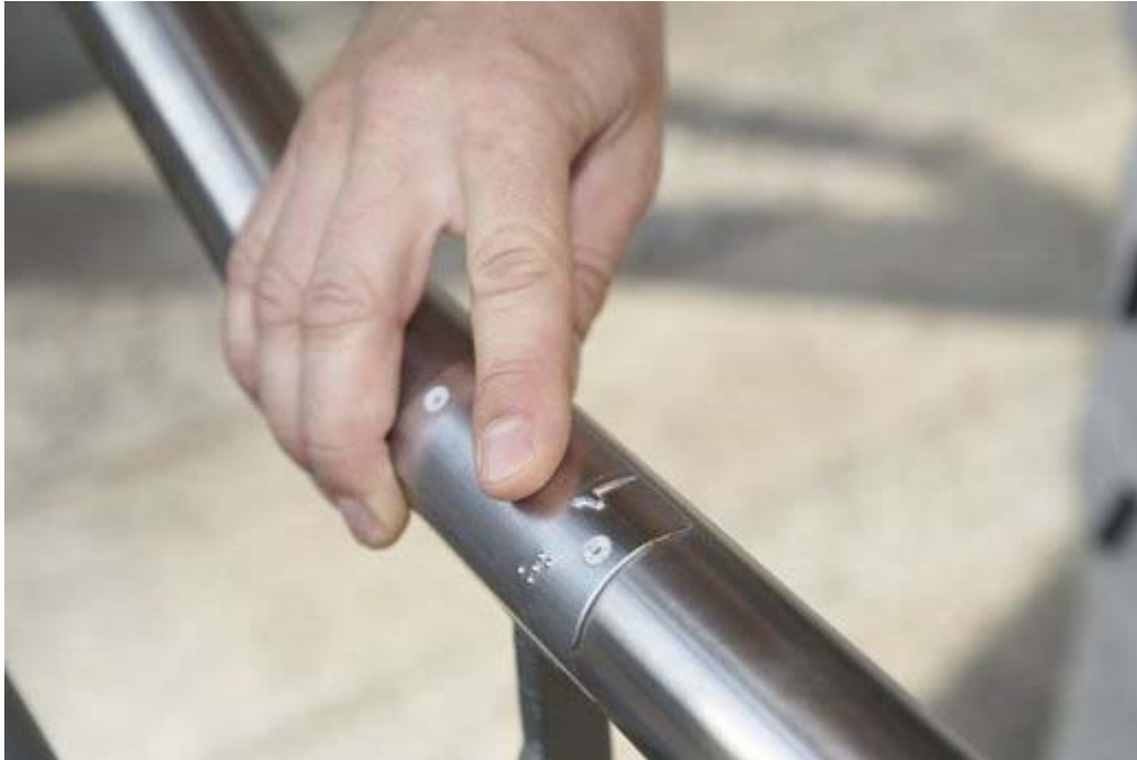
Stockwerkmarkierung am Handlauf
