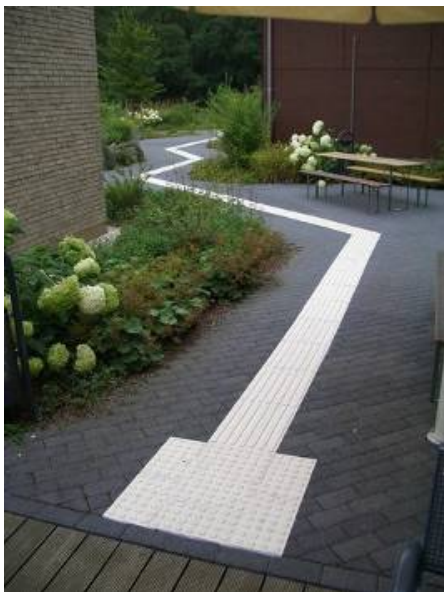
Leitsystem im Außenbereich
